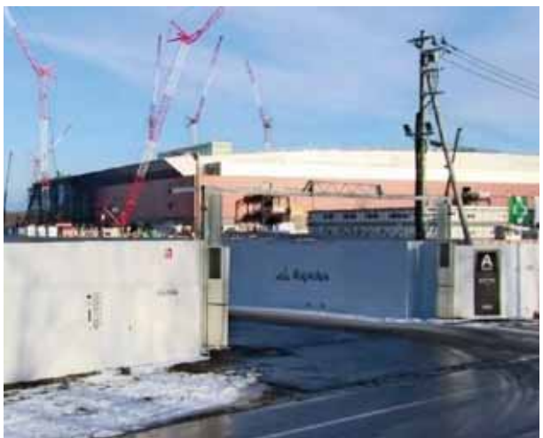
ラピダス工場の建設が進む北海道千歳市
