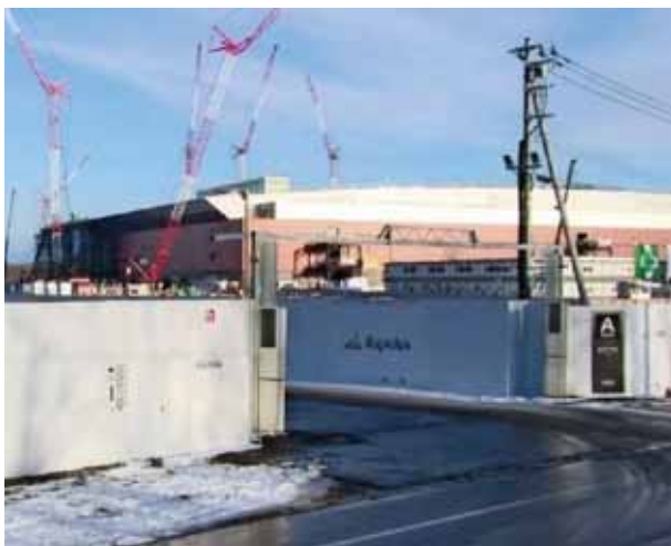
ラビダス工場の建設が進む北海道千歳市
