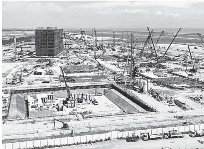
駐屯地開設にむけ工事が強行される佐賀空港北西側
