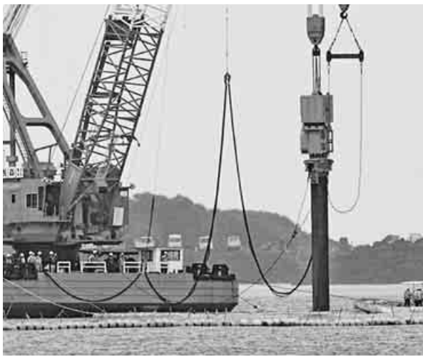
A 護岸築造へ杭打ち開始 (8月20日)
