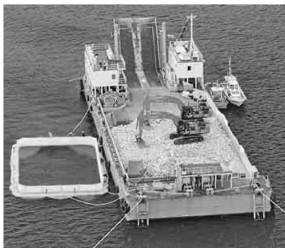
大浦湾で始められた工事
